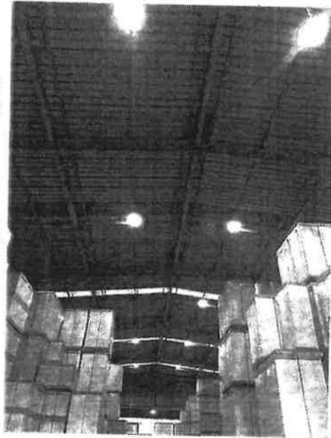
LED照明約120個を新規導入し、全て水銀灯から切り替えた同社物流センター
